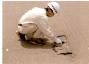
④YKパック施工完了(即時交通開放)
