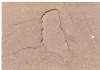
②YKパック施工完了(即時交通開放)
