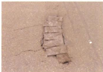
②YKパック施工完了(即時交通開放)
