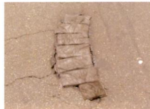
④YKパック施工完了(即時交通開放)
