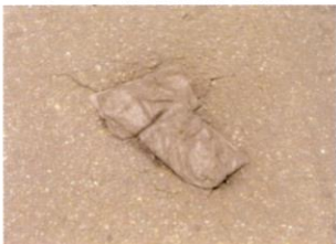
④YKパック施工完了(即時交通開放)
