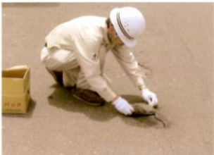
④YKパック施工完了(即時交通開放)
