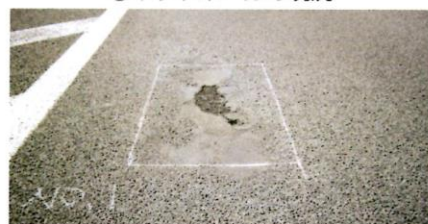
②ポットホール周辺撤去
