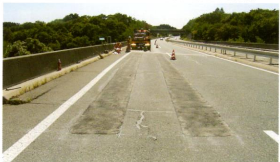
⑥わだち掘れ補修完了 (施工後即時交通開放)
