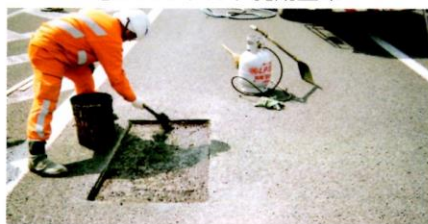
④PP アスコン投入
