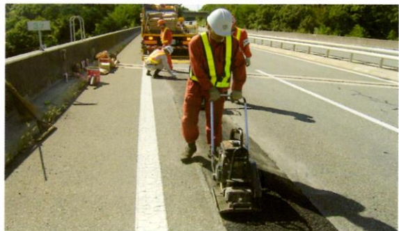
⑥わだち掘れ補修完了 (施工後即時交通開放)
