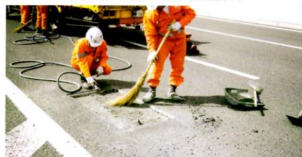
③アスファルト乳剤塗布
