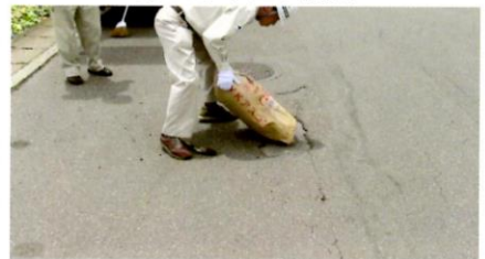
④YKアスコン敷き均し(既設舗装より高く盛る)
