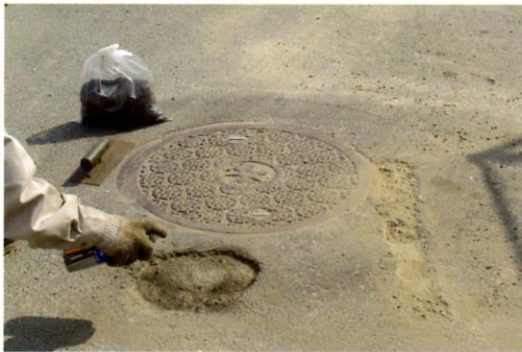
②タックコート施工(アスファルトスプレー)
