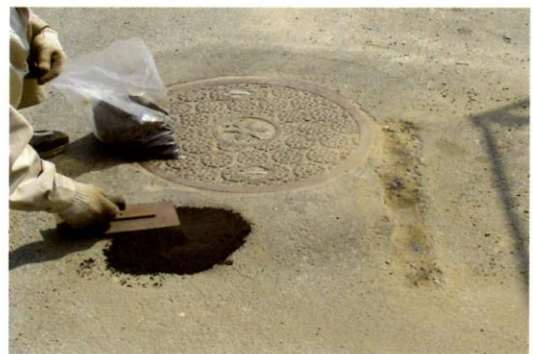
④敷き均し(金ゴテ)
